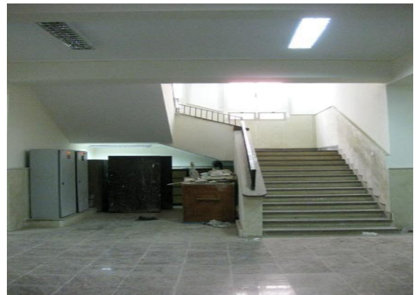
شكل (13) السلالم الرئيسة بالمبنى الجديد. الباحث: صورة من الواقع.
