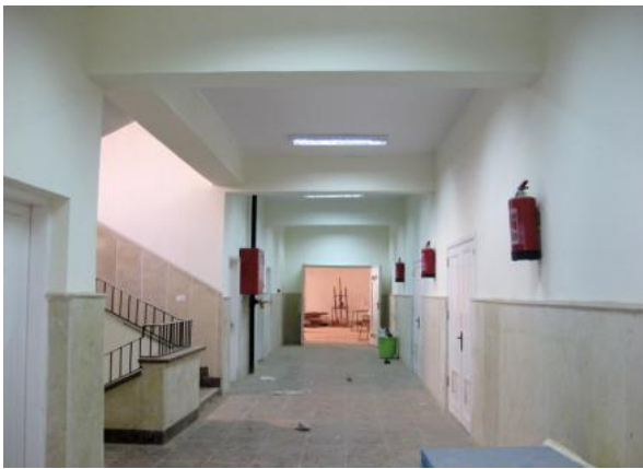
شكل (15) أحد الممرات الرئيسة بالمبنى الجديد. الباحث: صورة من الواقع.
