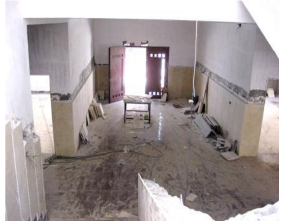
شكل (11) المدخل والسلم أثناء عملية التنفيذ. الباحث: صورة من الواقع.
