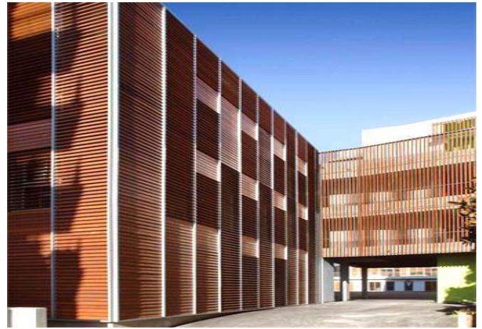
شكل (4) (7p 185) حماية المبنى من أشعة الشمس، مدرسة بول فاليري العليا بمينتون، فرنسا، تصميم N+B Architectes 2009
