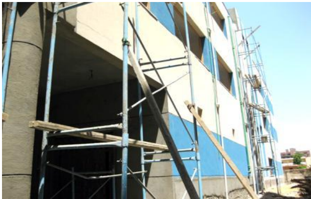
شكل (9) الواجهة الخلفية أثناء عملية التنفيذ. الباحث: صورة من الواقع.
